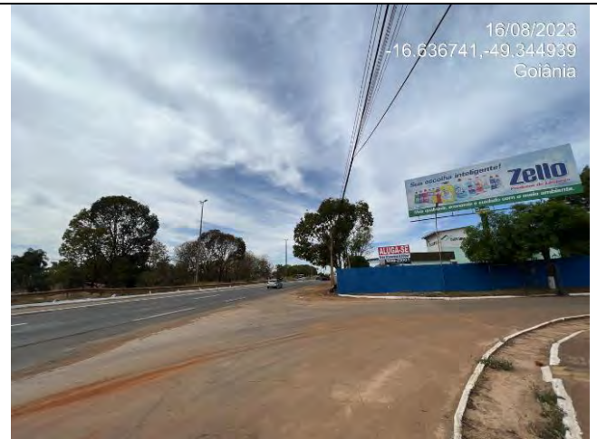
Vista da Rodovia GO-070
