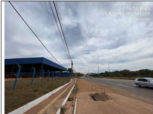
Vista da Rodovia GO-070
