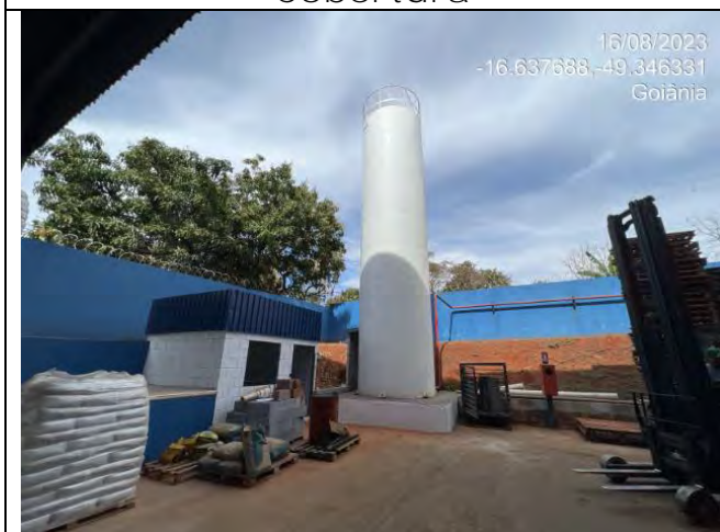
Reservatório de Água
