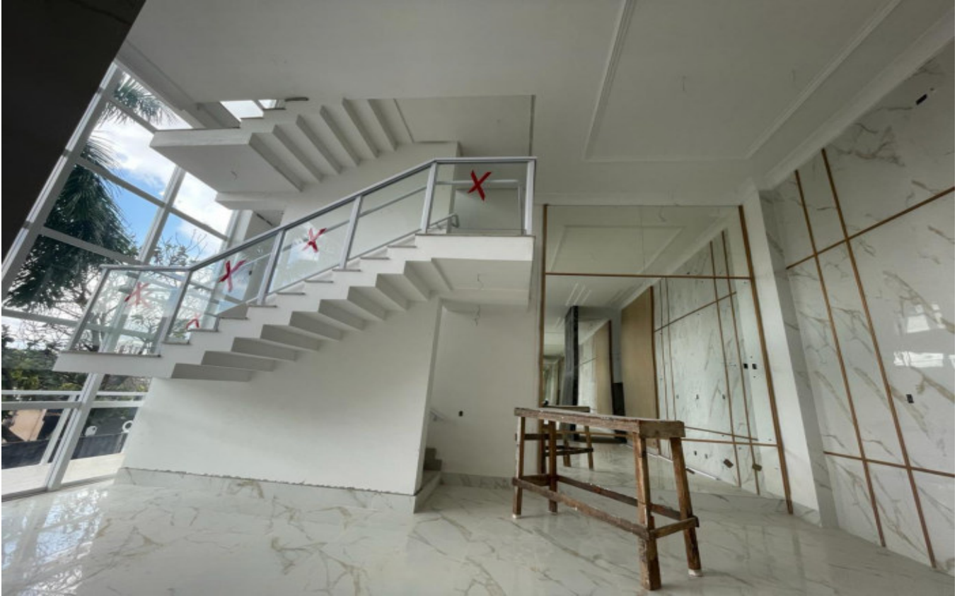
Figura 05 – Finalização de instalação de vidros do guarda corpo da escada – Pavimento Térreo.
