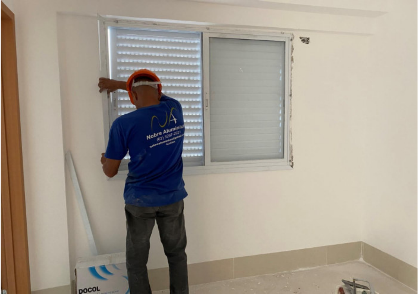
Figura 18 – Instalação de janelas dos apartamentos – 18º Pavimento.
