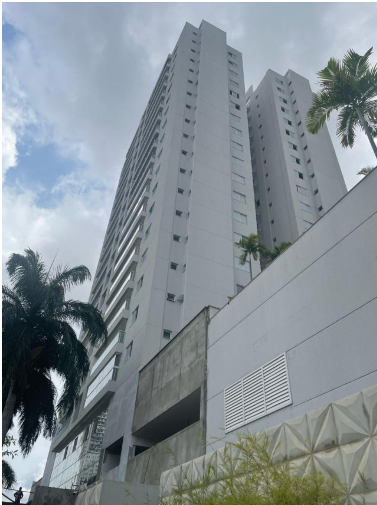
Figura 04 – Execução de textura externa na fachada lateral.
