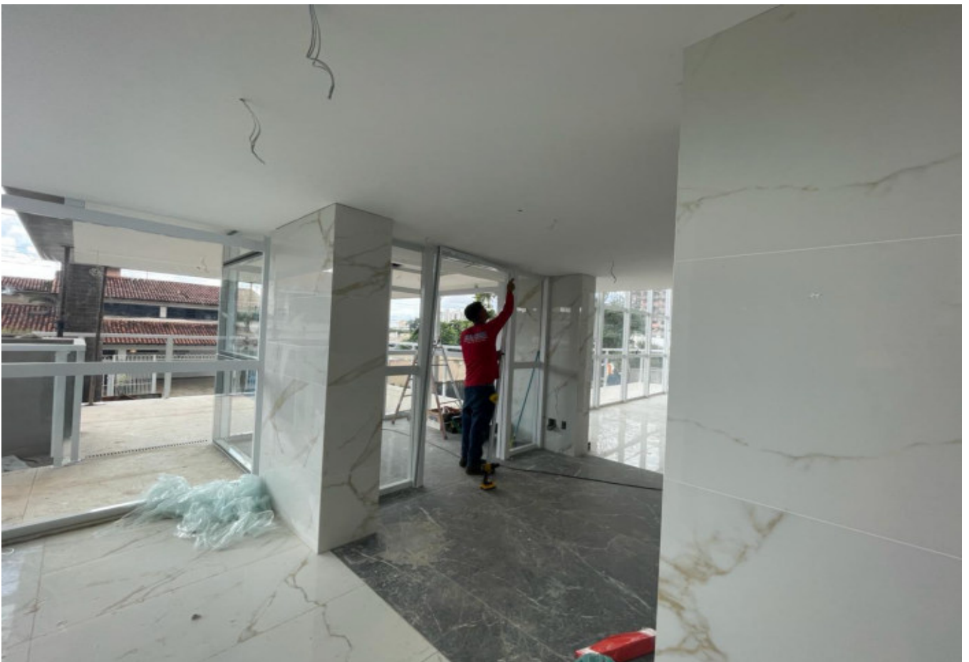
Figura 06 – Instalação de esquadrias de vidro da clausura – Pavimento Térreo.
