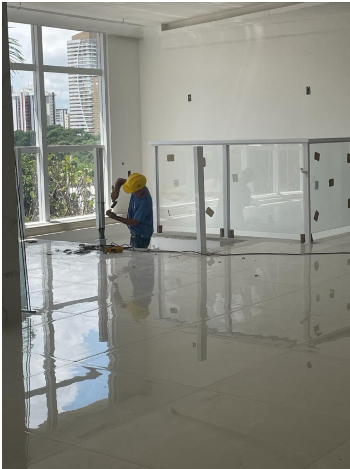
Figura 09 – Instalação de guarda corpo de vidro da escada – Pavimento Lazer.
