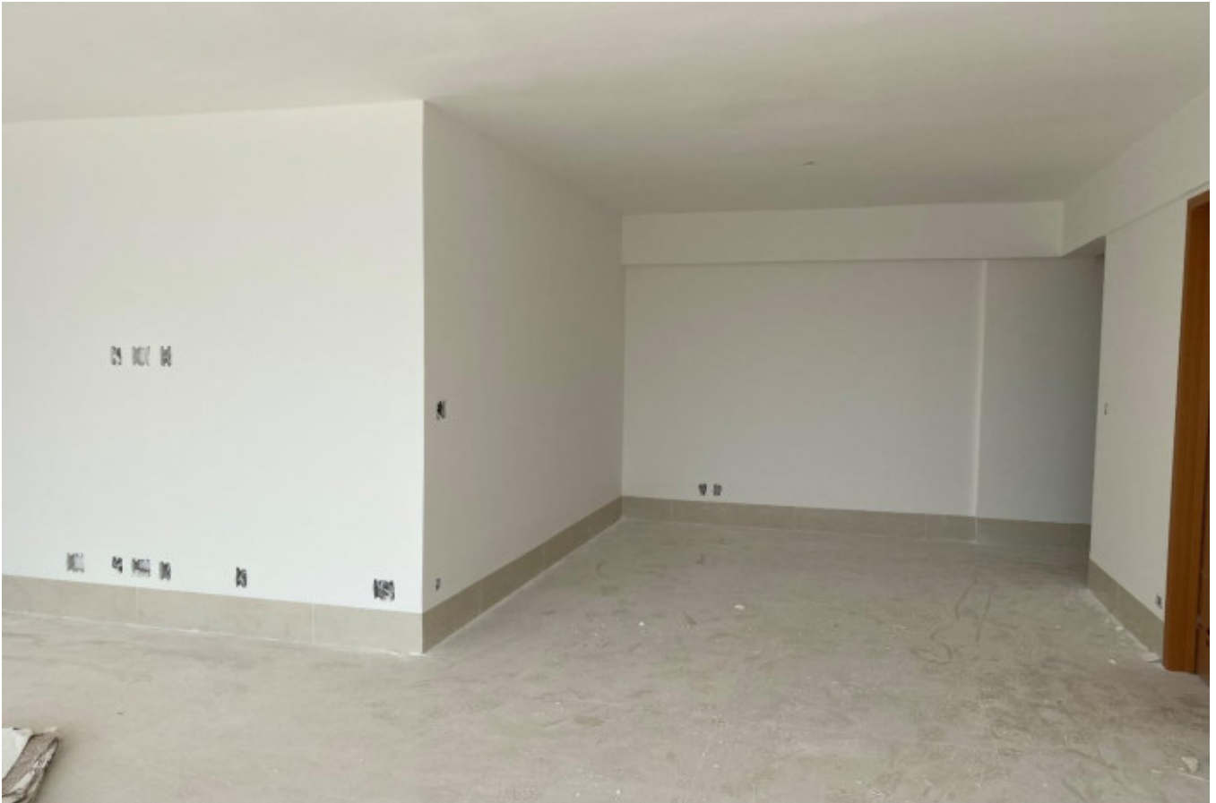
Figura 14 – Execução de pintura PVA – 10º Pavimento.
