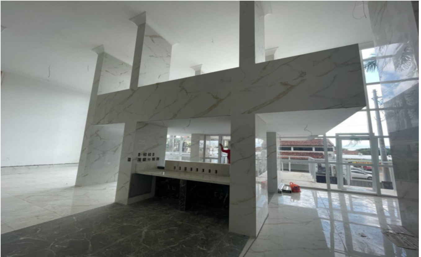
Figura 07 – Assentamento de porcelanato nas paredes do hall – Pavimento Térreo.
