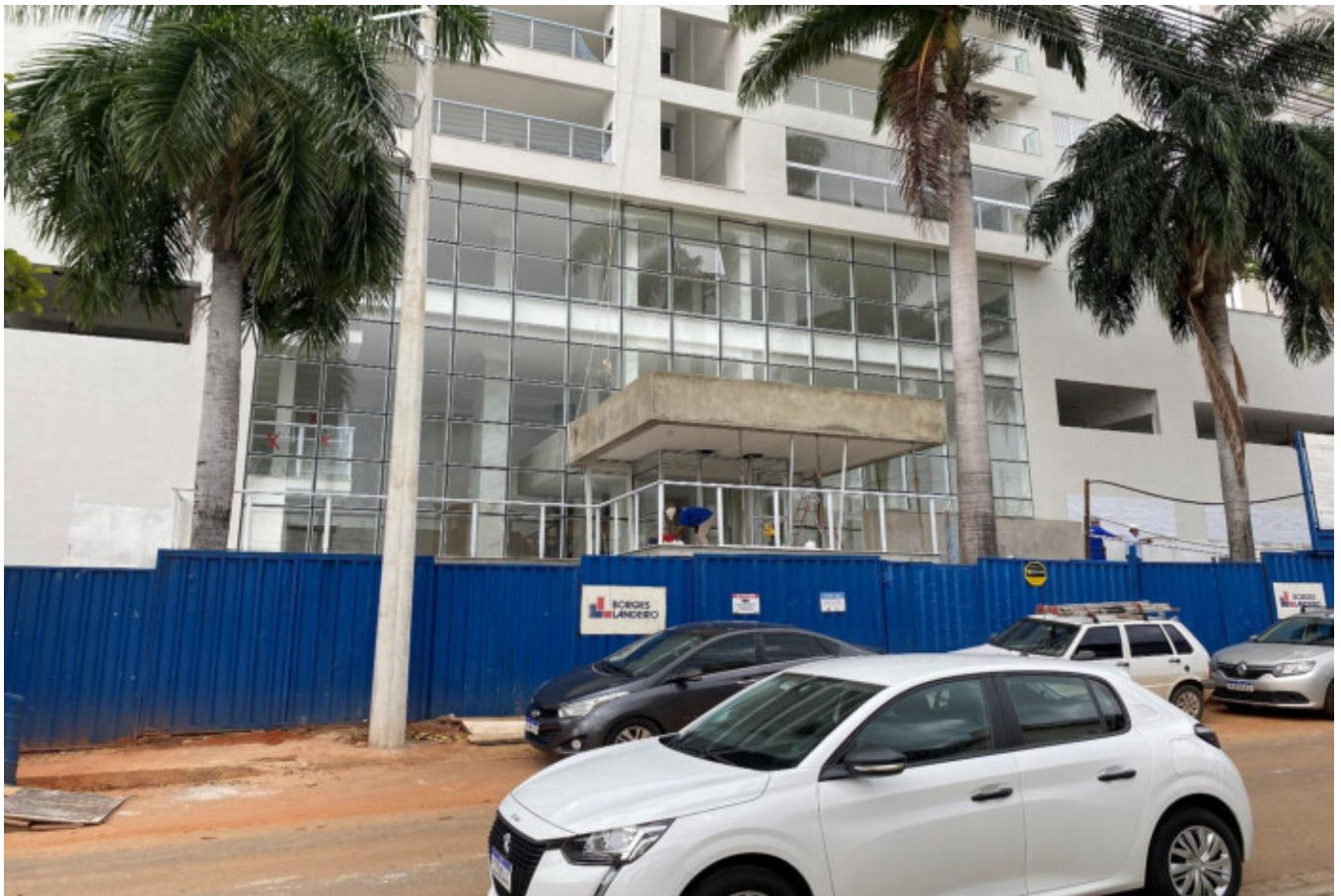
Figura 02 – Instalação de guarda corpo de vidro do hall externo.
