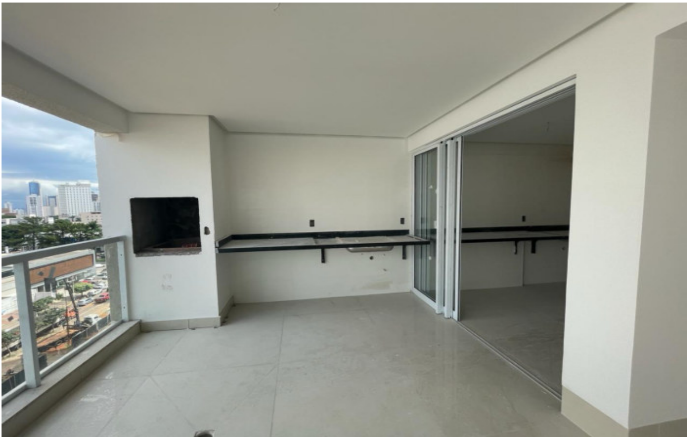
Figura 15 – Execução de pintura acrílica em parede da sacada – 10º Pavimento.
