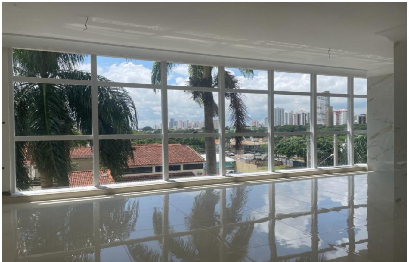
Figura 03 – Finalização de instalação de pele de vidro da fachada.
