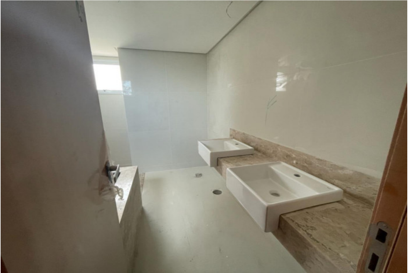
Figura 12 – Instalação de cubas de louça – 8º Pavimento.
