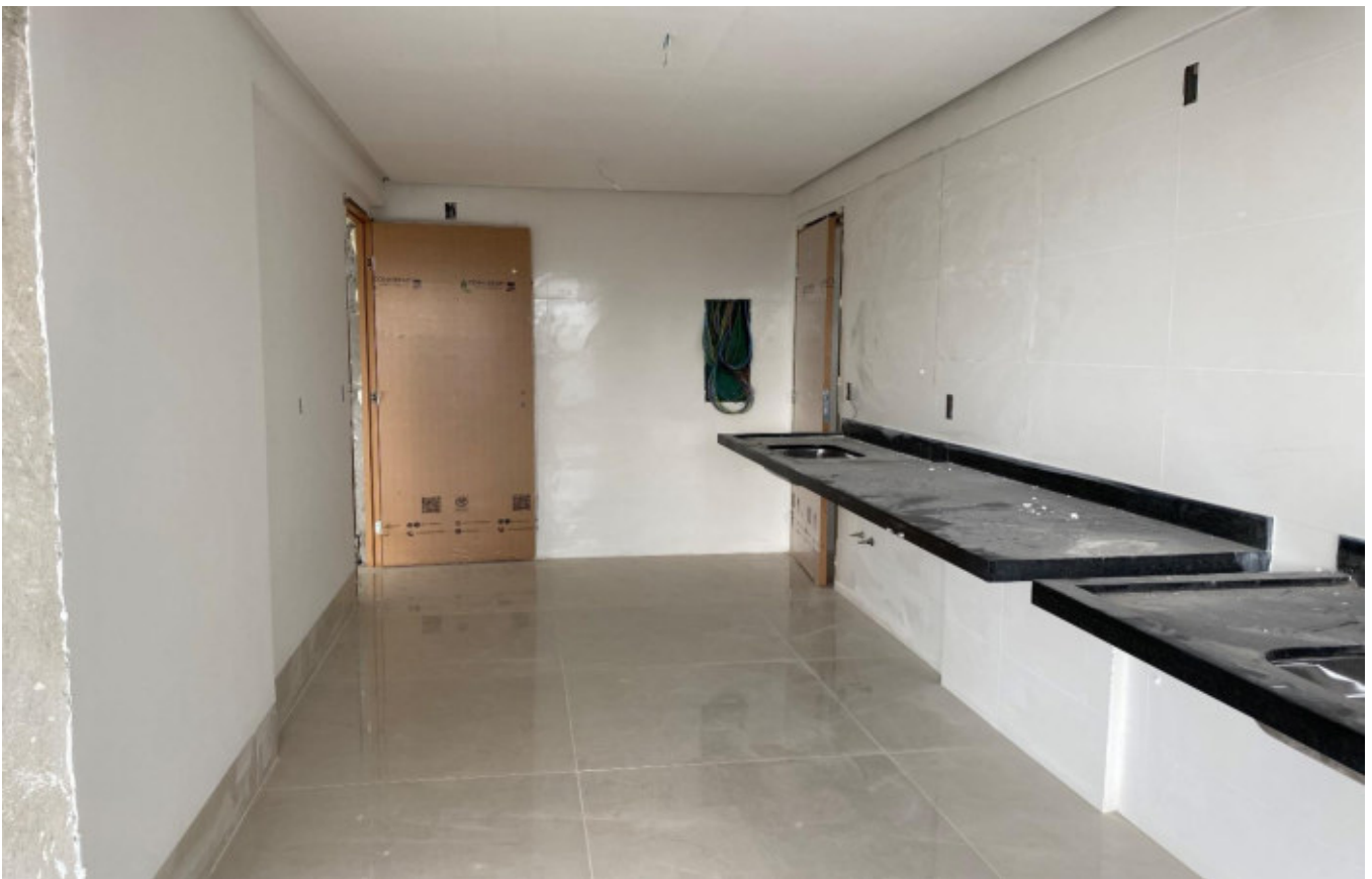
Figura 17 – Instalação de portas de madeira dos apartamentos – 16º Pavimento.
