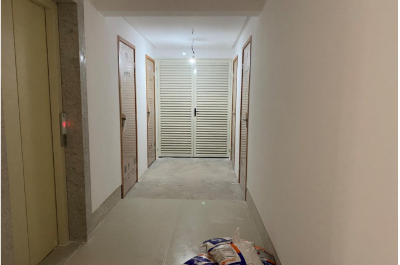
Figura 16 – Instalação de portas de madeira dos escaninhos – 16º Pavimento.
