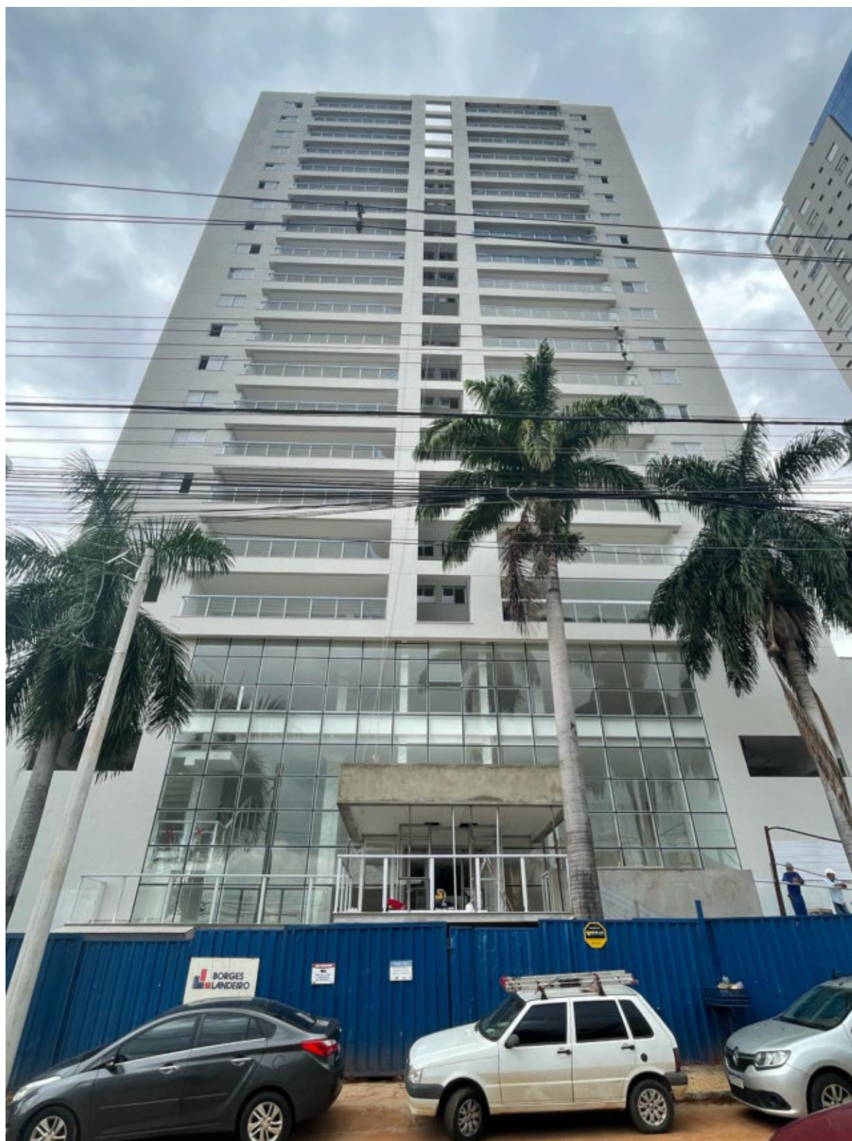
Figura 01 – Fachada da obra Prime – Vista pela Rua 1.125.
