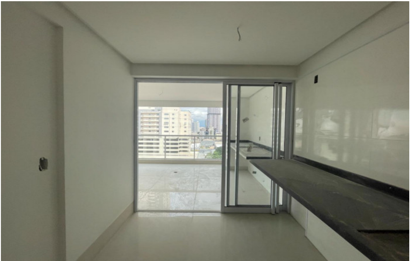
Figura 13 – Instalação de porta de vidro da sacada – 8º Pavimento.
