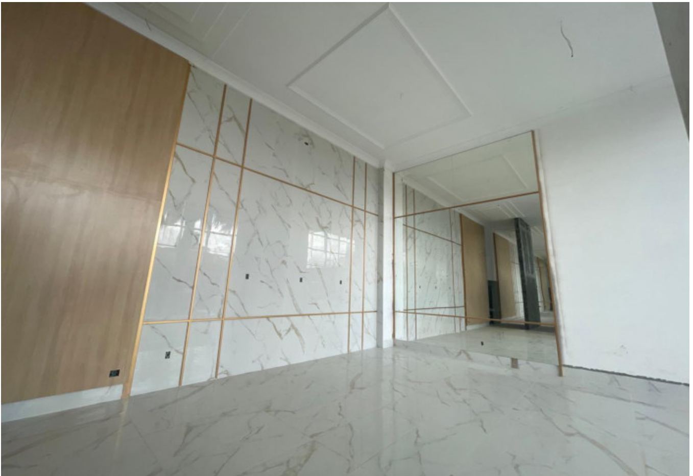
Figura 08 – Assentamento de porcelanato nas paredes do hall e instalação de espelhos – Pavimento Térreo.
