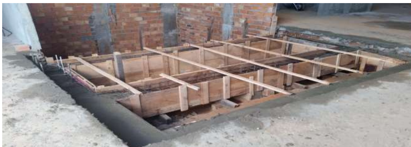
(Construção do escritório no segundo galpão)
