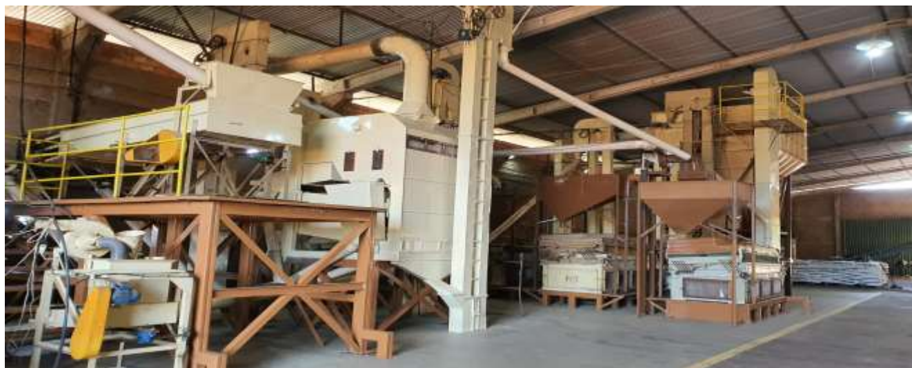
(Registro das máquinas e galpão após as reformas)
