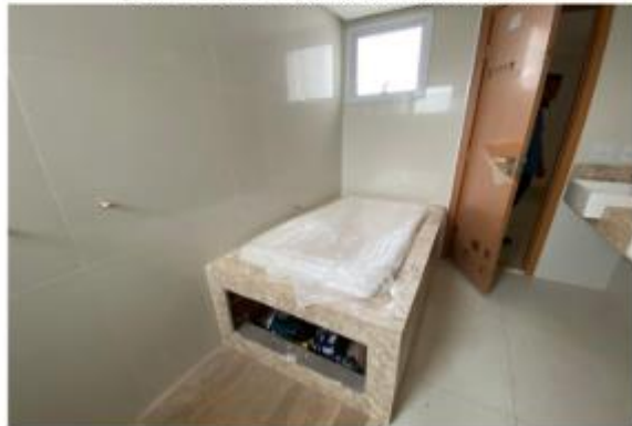
Figura 03 – Finalização da instalação das banheiras dos apartamentos.
