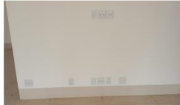
Figura 04 – Finalização da instalação do aquecimento elétrico dos apartamentos.
