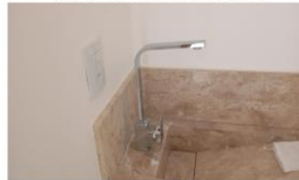
Figura 05 – Finalização da instalação das torneiras dos apartamentos.
