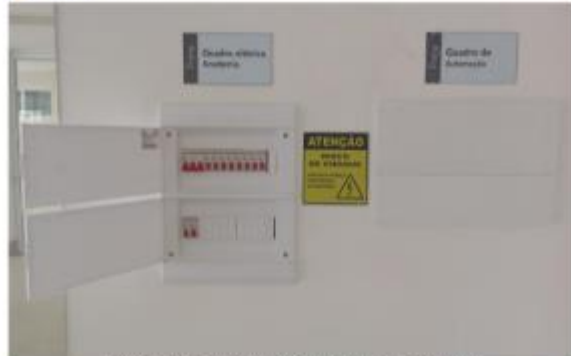
Figura 02 – Finalização da instalação dos quadros elétricos da área comum.
