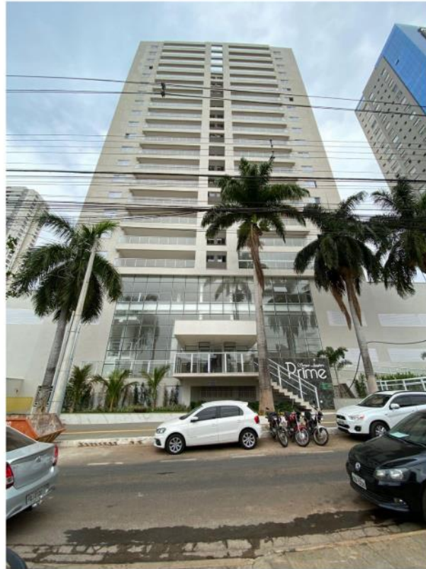
Figura 01 – Fachada da obra Prime – Vista pela Rua 1.125.
